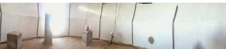
Een panoramisch zicht van de binnenzijde van het magnetisch observatorium. De verschillende pijlers zijn ontworpen om er meetinstrumenten op te plaatsen.
